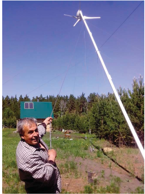
Рис. 2. Монтаж ветроэлектрической установки для электроснабжения дачного участка
